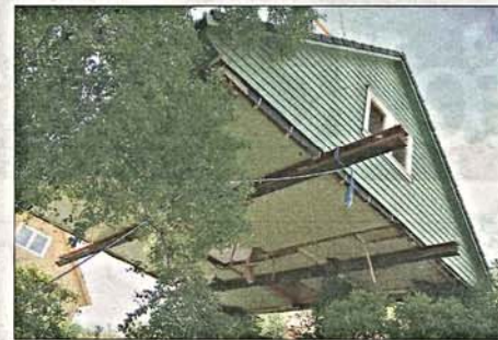
BORTE: Mens loftsetasjen dinglet i luften, ble etasjen under nøye revet med grave-maskin. Deretter ble takpartiet forsiktig tredd nedover pipen igjen. FOTO: MÜLLER/ÅDLANDSVIK
