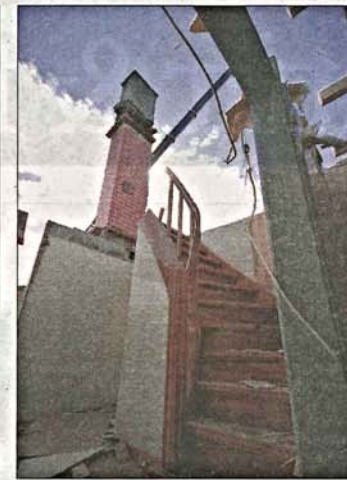
BORTE: Mens loftsetasjen dinglet i luften, ble etasjen under nøye revet med grave-maskin. Deretter ble takpartiet forsiktig tredd nedover pipen igjen. FOTO: MÜLLER/ÅDLANDSVIK
