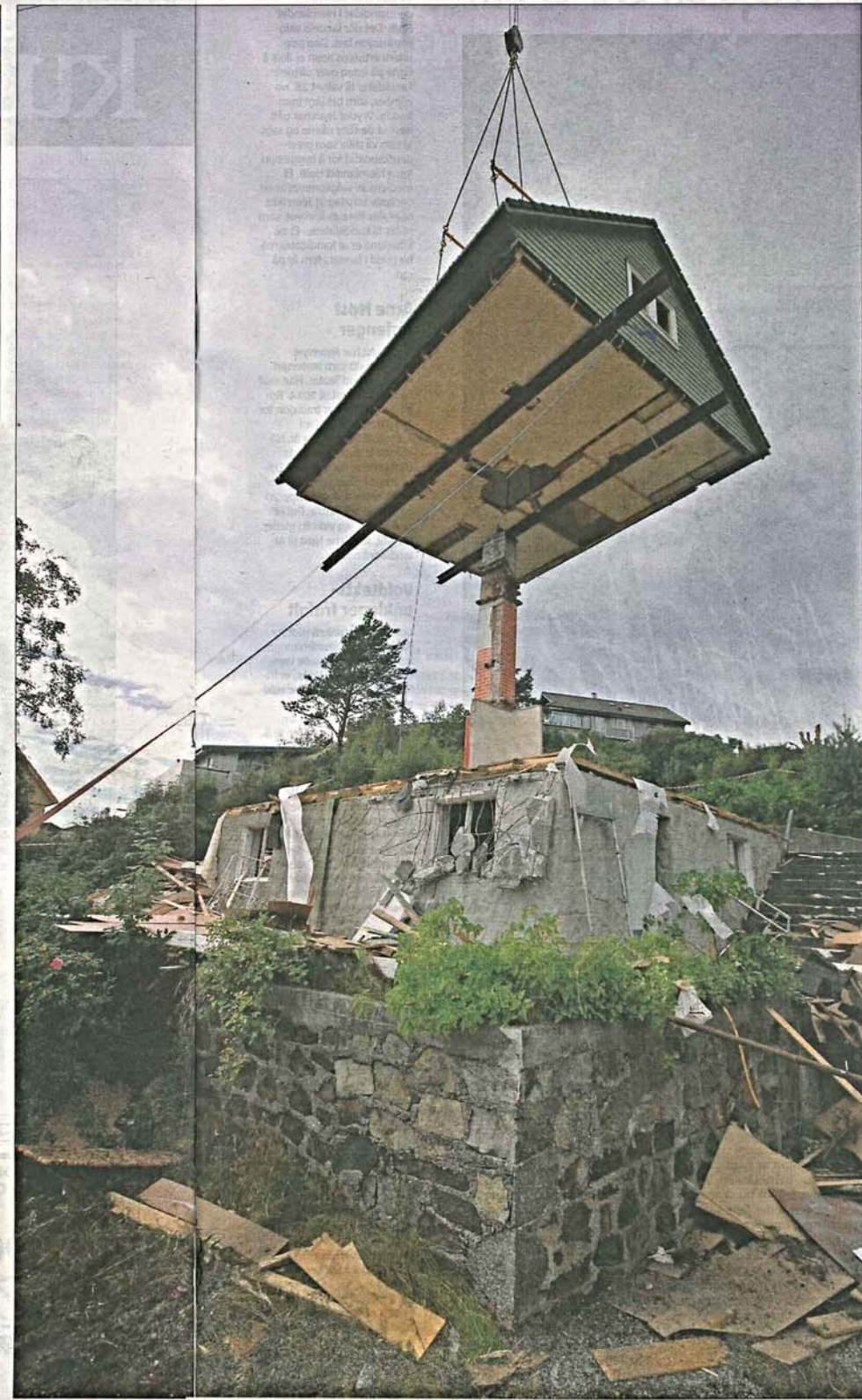
VELLYKKET: Presisjons-løfting var fornømt da Holmedalshammaren 67 på Askøy ble forvandet til kunstverk torsdag. Utfordringen var å unngå at pipen raste sammen. FOTO: MÜLLER/ÅDLANDSVIK
